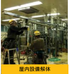
屋内設備解体
