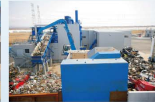
シュレッダープラントでの破碎・選別処理
