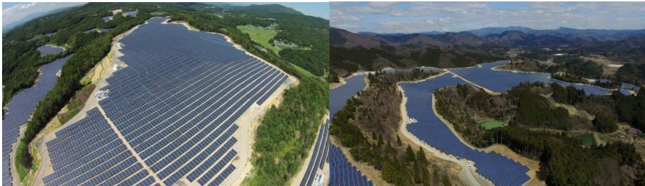
久米南メガソーラー発電所
