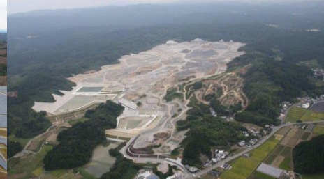
細江メガソーラー発電所
