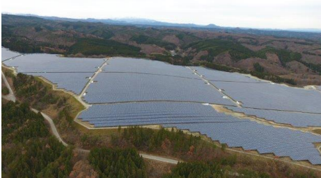
古川メガソーラー発電所
