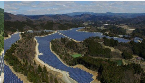
美作武蔵メガソーラー発電所
