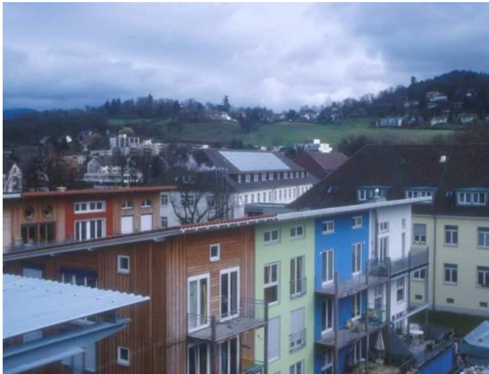
Solar Siedlung Vauban ( Freiburg )
