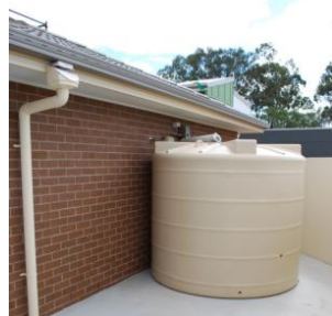
住宅設置の雨水貯留槽
