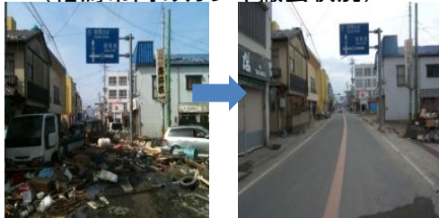
(相馬市内のガレキ撤去状況)
