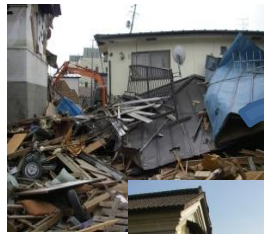
(撤去前と撤去後(宮古市))
