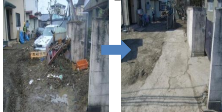
(仙台市内(住宅地)の撤去状況)
