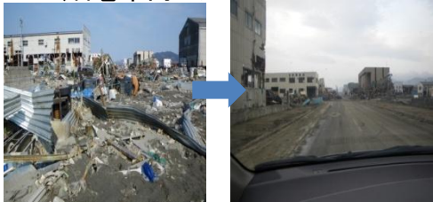
(石巻市内のガレキ撤去状況)
